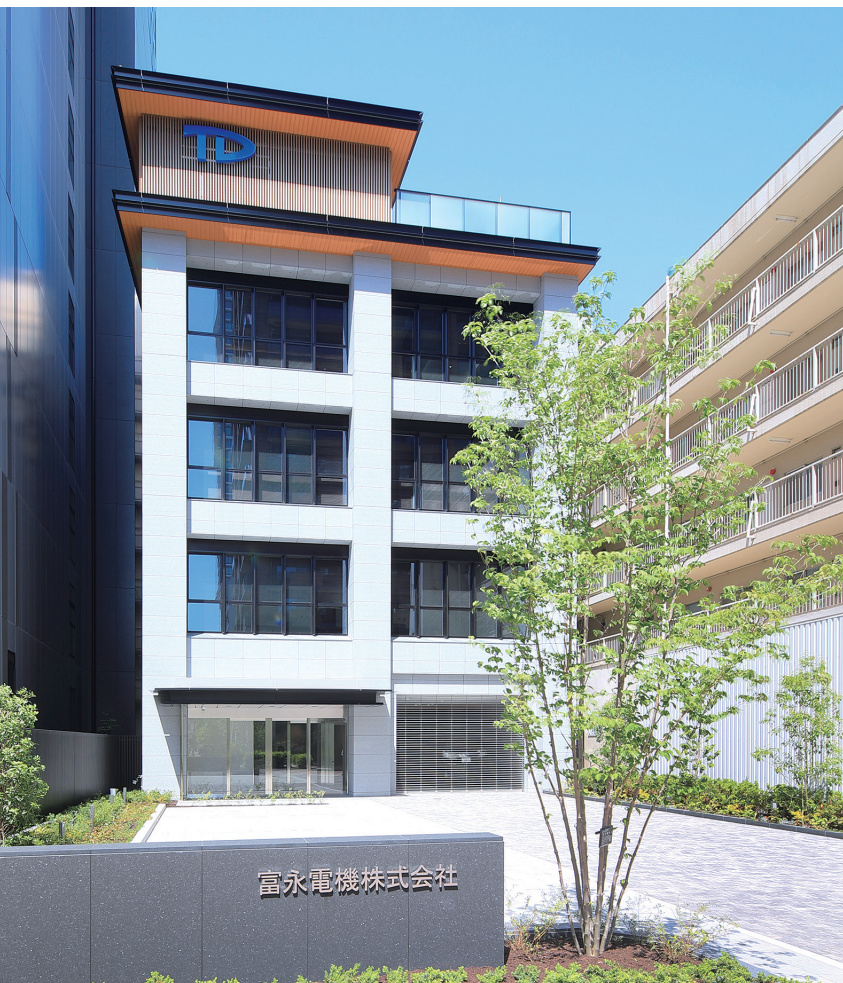
Photo / 富永電機 本社ビル 新築工事 施工:杉本組
